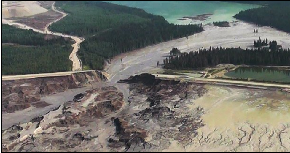
Şekil 4. MountPolley Bakır ve Altın Madeni'ndeki siyanür atık barajının patlaması (41).
